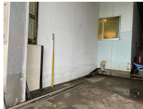
(左) 富来漁港の倉庫内と (右) 赤住漁港 (南) の倉庫外壁に残された津波痕跡。2024年1月5日撮影。
