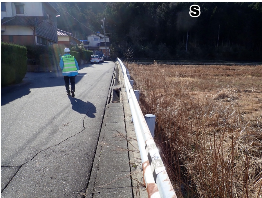
図 15 盛土地盤の側方流動によるとみられるはらみ出しで生じたガードレールの見かけ上の右ずれ。北に向かって撮影。（志賀町富来地頭町甲）
