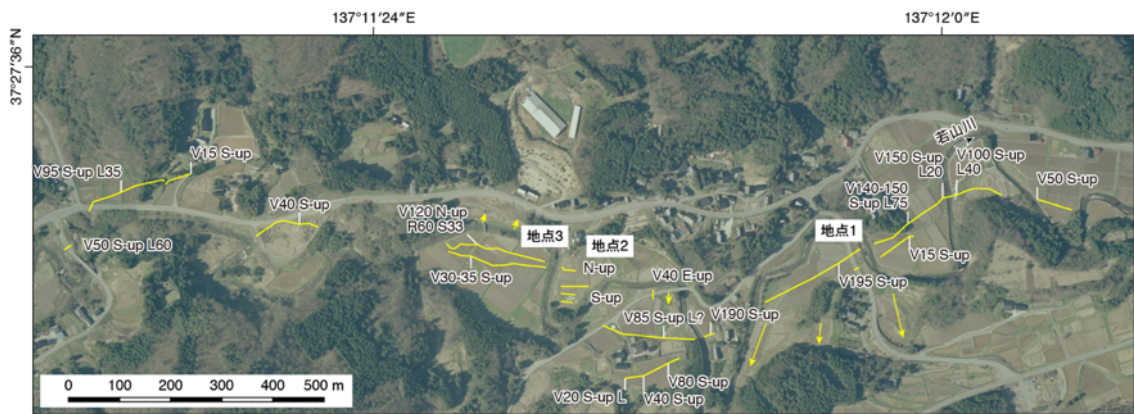
図3 今回の調査で観察した地表変状（若山町中）。本図の範囲を図2に示す。基図は国土地理院航空写真を用いた。
