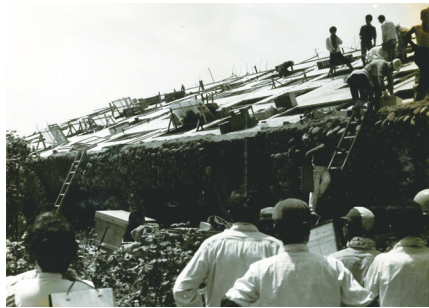
液状化現象により倒れたアパート (新潟地方気象台ホームページ「新潟地震から60年」特設サイトより引用)
