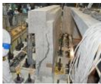
衝突後の擁壁の状況
