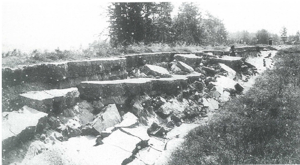
木曽川堤防破壊
