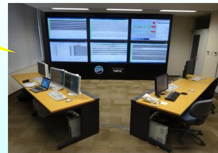
データセンター
