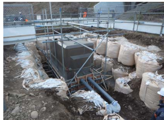
陸揚げに先立ち ビーチマンホールの設置
