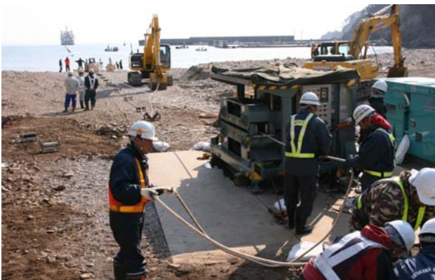
重機でケーブルを巻き取り
