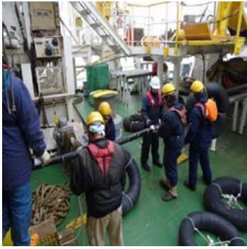
ケーブルヘブイの取り付け（KPL船上）
