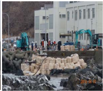
ケーブル陸揚げ（旧海洋学院）
