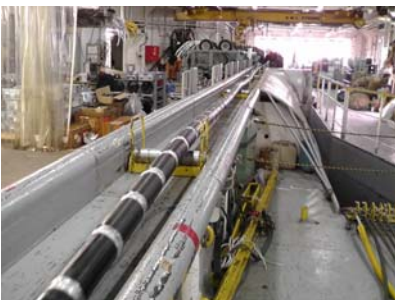
DAケーブル（直径41mm）に直径93mmの ポリウレタン防護管を被せて繰り出し
