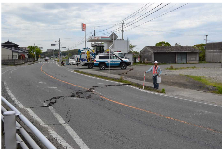
地点2（飯田） 垂直方向に約15 cm, 断層と直交方向に約10 cm程度。右横ずれ成分はほとんどなく、正断層型がメイン
