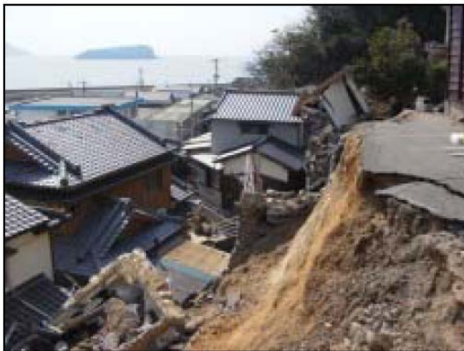
図 9-19 福岡県西方沖の地震による崖崩れで損壊した道路（福岡市玄海島）〔気象庁（2005）より〕
