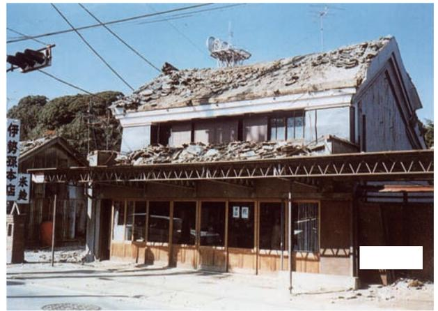
図5-24 千葉県東方沖の地震による瓦屋根家屋の被害
