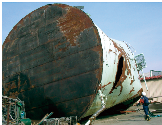
図3 2011年東北地方太平洋沖地震の際の津波で流された石油タンク(宮城県気仙沼市)
