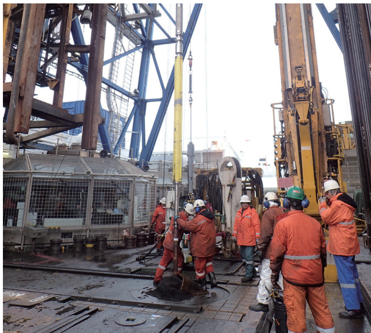
図3 「ちきゅう」船上における孔内センサー編成の組み上げ作業(写真は歪計)
