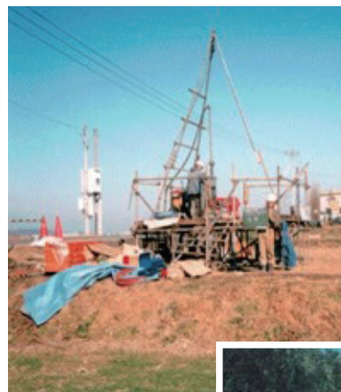
写真 1 ボーリング調査 写真は深谷断層帯の ボーリング調査の様子。 （群馬県藤岡市）
