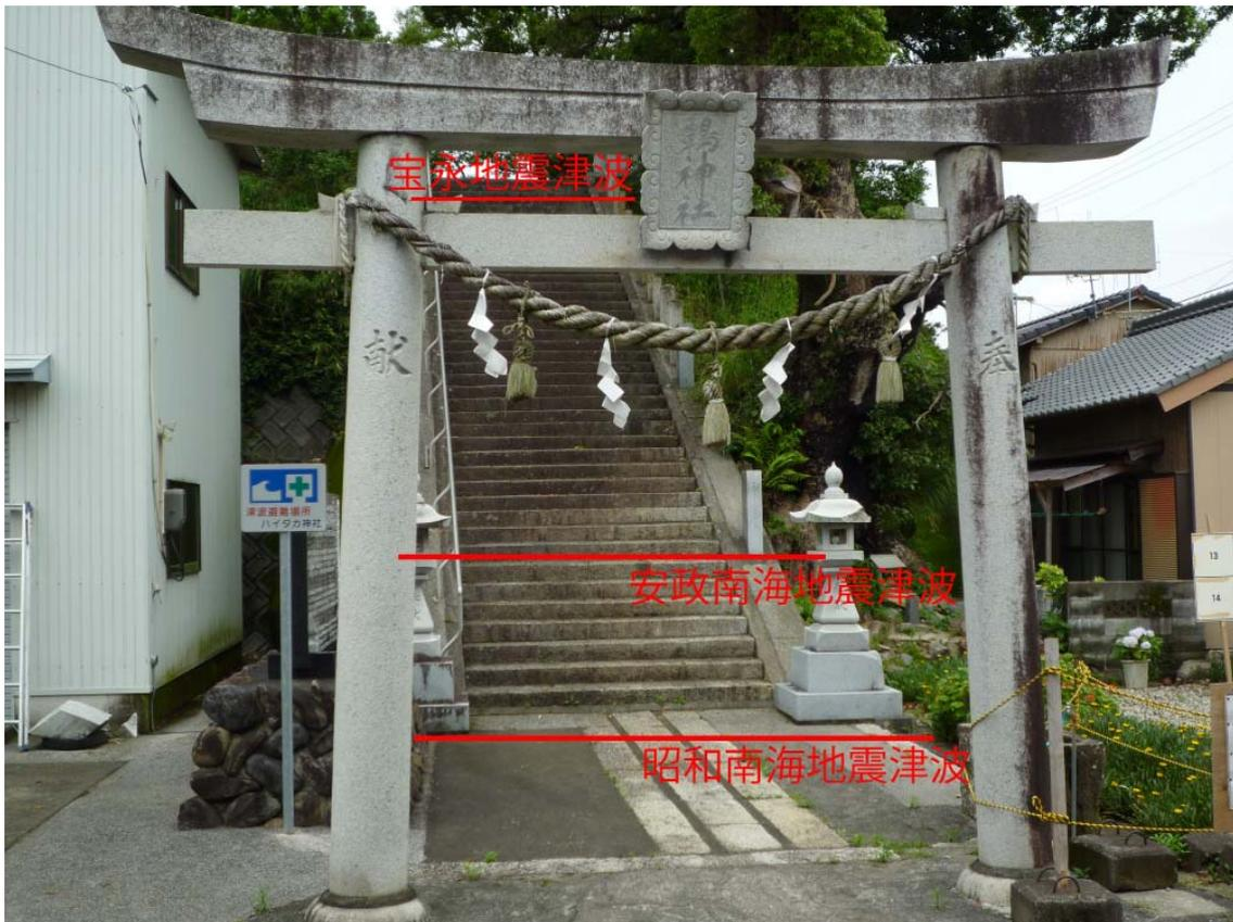
図13 高知県宿毛市大島のハイタカ神社の石段。1707年宝永地震では上から3段目まで(石段の下から測って7.3 m)、1854年安政南海地震では下から7段目まで(石段下から測って1.4 m)、1946年南海地震では石段の下まで津波が来た。
