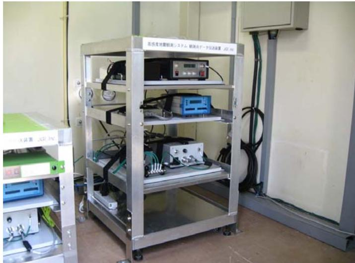
写真3 簡易ラックに固定された観測装置。地震計コントローラ(上段)、高精度 A/D 装置(中段) および高精度 A/D 装置用電源部(下段)等。左側に既存 Hi-net 様のラックが見える。
