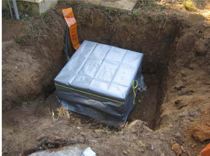
写真2 埋設直前の地震計室の様子。防水・断熱シートで覆ってある。
