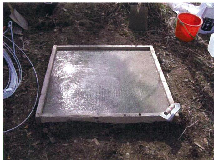
写真1 地震計台座（コンクリートベース）の構築。
