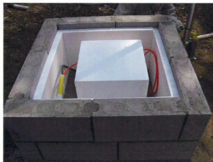
写真4 地震計用保温箱の設置。
