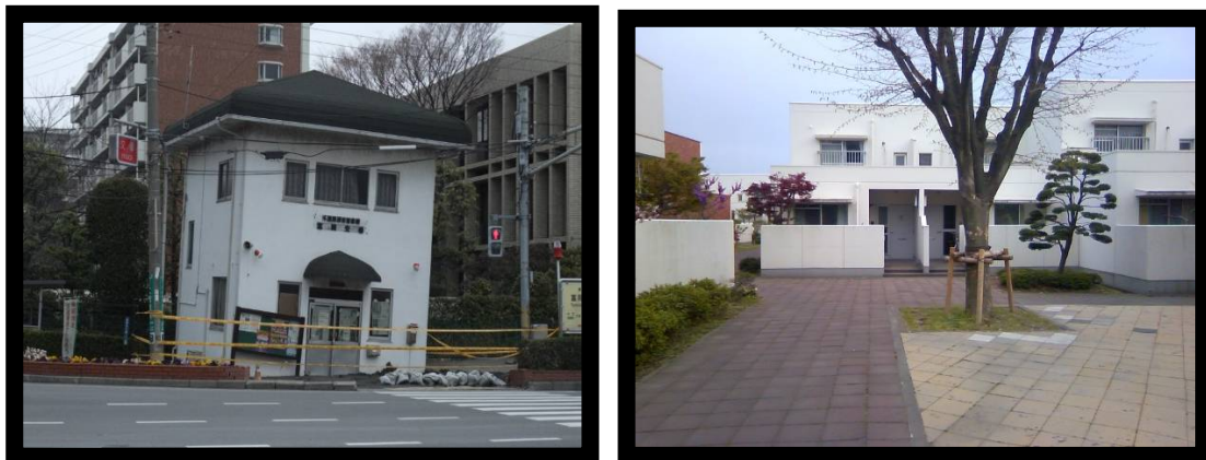
(a) 液状化による構造物の傾倒 (未対策) (b) 液状化対策によって無被害
