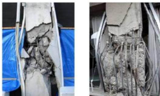
図3-1-⑤-1 柱のせん断破壊(国総研・建研, 2012)
