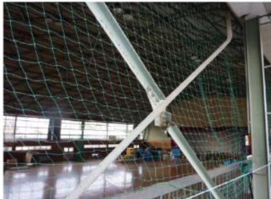
(a) ブレースの座屈と接合部破断
