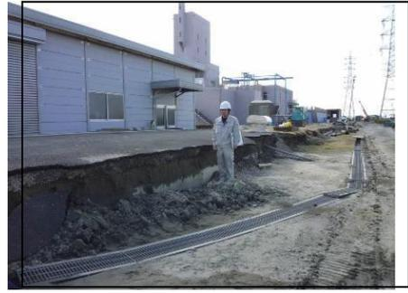
図 3-2-⑤-5 配水池の地震動被害 図 3-2-⑤-6 浄水場の液状化被害
