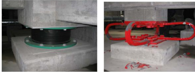
(a) 積層ゴムと U 型鋼材ダンパー
