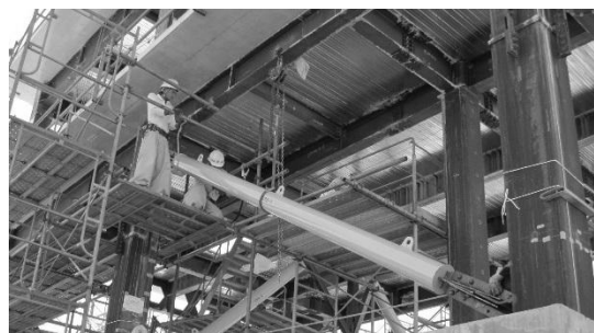
(a) ダンパーの取り付け状況
