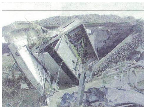
図 3-2-⑤-3 南明戸水源場
