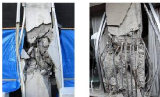
図3-1-⑤-1 柱のせん断破壊(国総研・建研, 2012)
