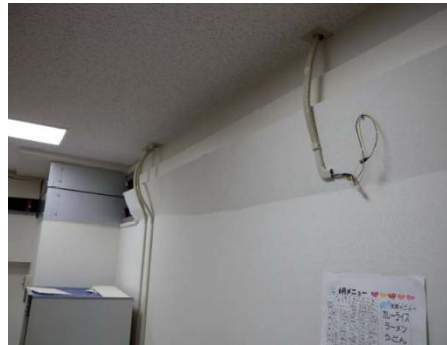
図 3-1-⑤-14 エキスパンジョイント部分の損傷 (国総研・建研, 2012)
