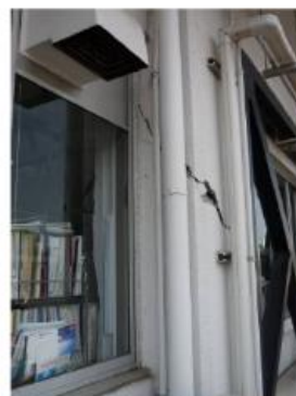
(b) 建築物J（損傷度IV）
