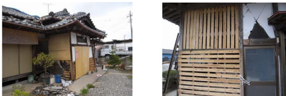
図 3-1-⑤-9 木造建物の被害 (国総研・建研, 2012)
