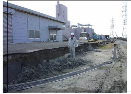
図 3-2-⑤-5 配水池の地震動被害 図 3-2-⑤-6 浄水場の液状化被害
