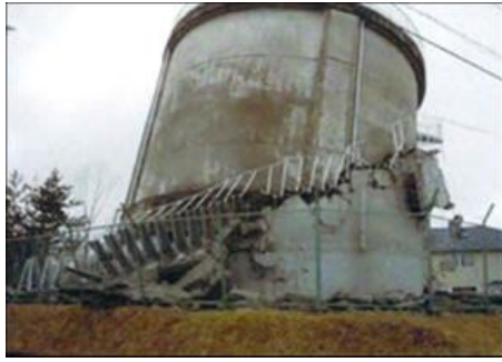
図 3-2-⑤-5 配水池の地震動被害 図 3-2-⑤-6 浄水場の液状化被害
