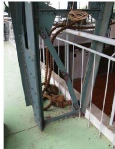
(b) ラチス柱斜材の座屈
