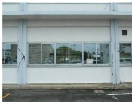
(a) 建築物H（損傷度IV）
