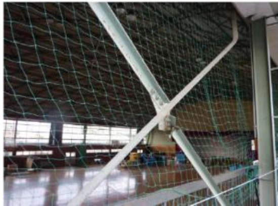
(a) ブレースの座屈と接合部破断
