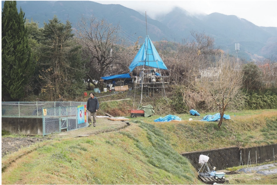
奈良県葛城市中戸における金剛断層帯山田断層のボーリング調査。2015（平成27）年12月24日に、西に向かって撮影。口径86mmで長さ10mのボーリングを、断層の推定通過位置の東西で1孔ずつ掘削した。
