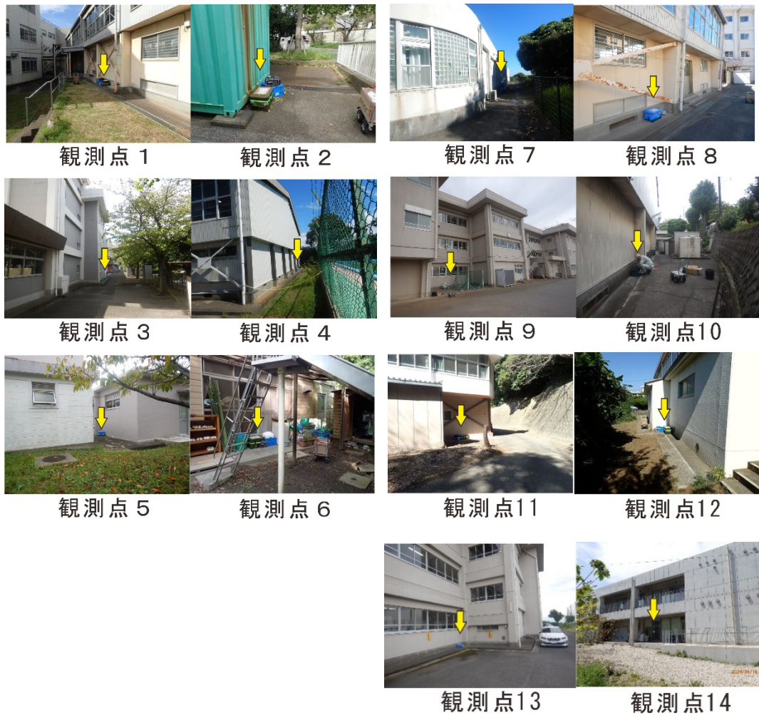
図6 各臨時強震観測点で観測機器の設置状況の例（矢印は設置した地震計）。
