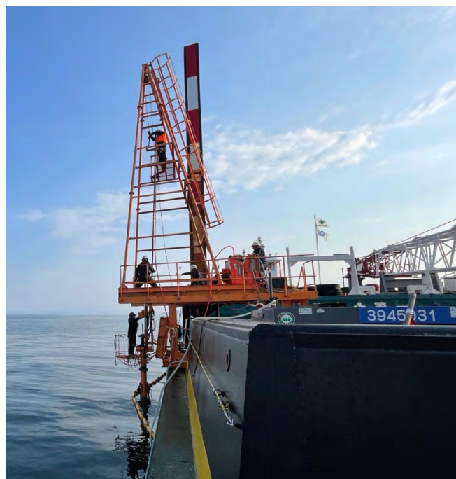
図 43 海上ボーリング調査の現場写真（上：調査船、下：ボーリング檣）
