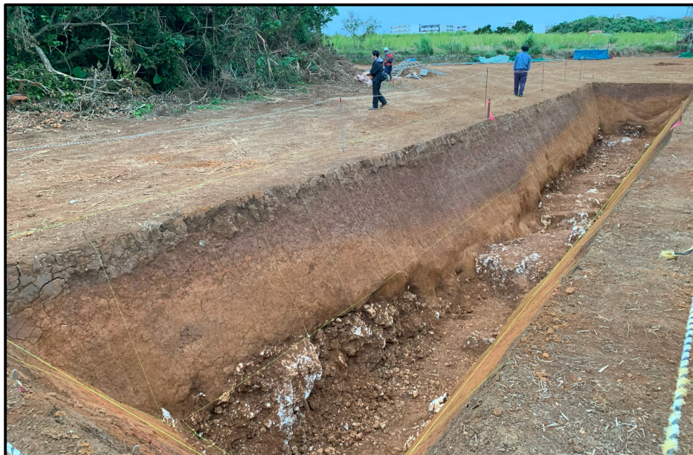
宮古島平良久貝地区において掘削したトレンチ
