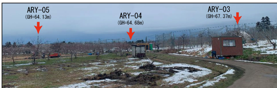
平川市新屋地区における群列ボーリング掘削の様子
