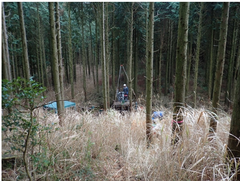
長崎県島原市内の国有林野で実施したボーリング調査風景（断層崖頂部から低下側（南）に向かって撮影）。
