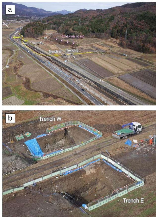
図9 飯田地点の斜めドローン写真。(a) 現在の姫川と地震断層、トレンチ掘削地点の関係。(b) 2014年長野県北部の地震で断層変位を被った農道とトレンチ。
