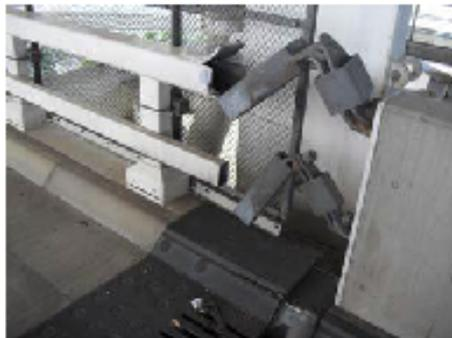
高欄伸縮継ぎ手の損傷
