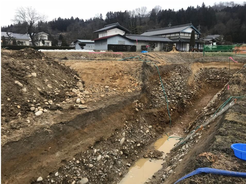
長野県安曇野市明科七貴において松本盆地東縁断層北部のトレンチ掘削調査を実施し、最新活動が7～13世紀、地震時上下変位量が約1mであることを明らかにした。
