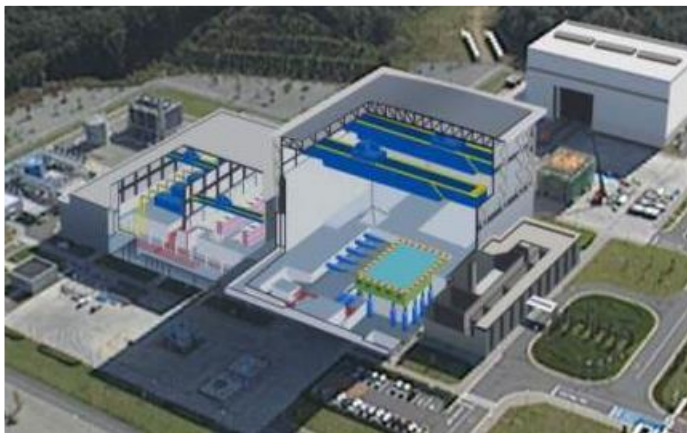
図 2.8 Eーディフェンスの概観図 (防災科学技術研究所, 2008b)。
