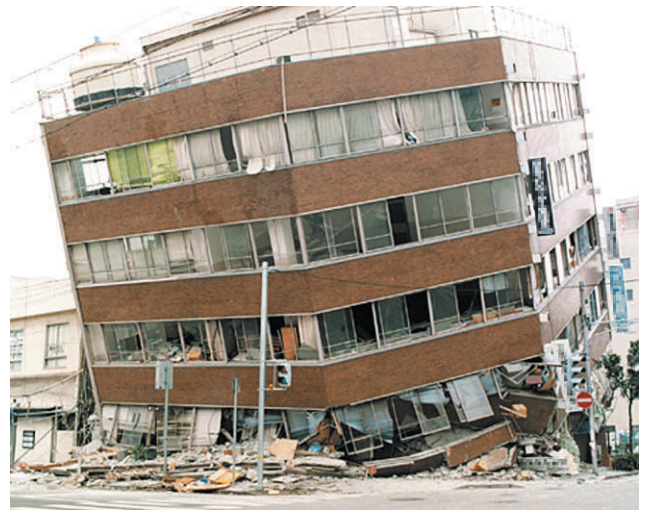
▲こわれたビル：阪神・淡路大震災／平成 7年(1995年)
