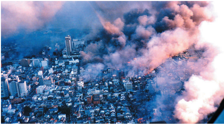
▲地震による火災：阪神・淡路大震災／平成 7年(1995年)
