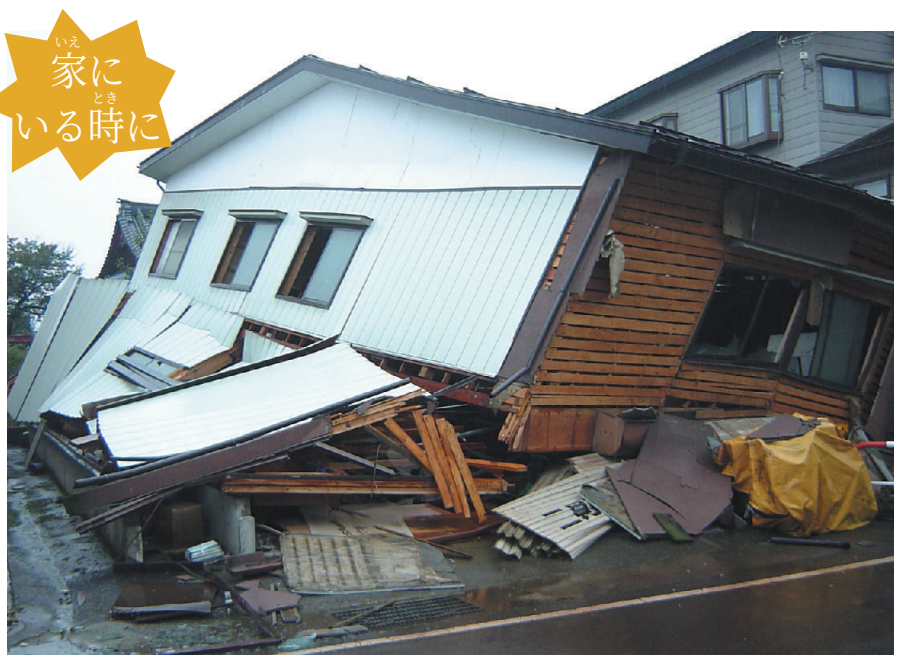
▲階がつぶれてしまった住宅：新潟県中越地震／平成 16年（2004年） ＊写真提供：首都大学東京土質研究室
