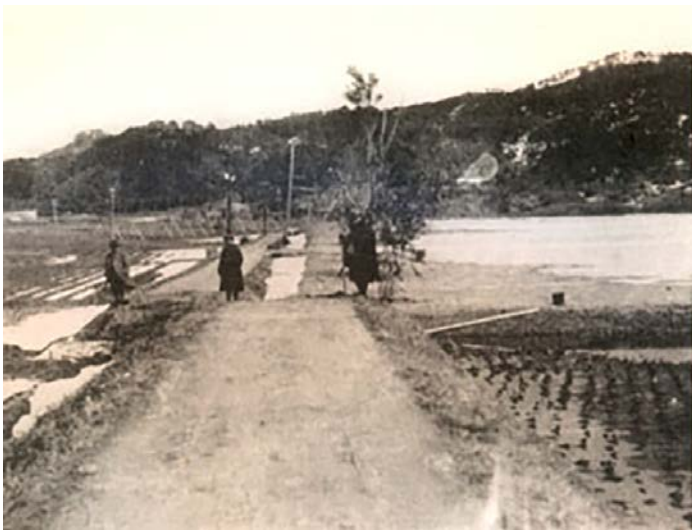
図 7-7 北丹後地震による道路の食い違い [海洋気象台撮影]
