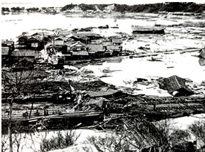
図 7-15 昭和南海地震の津波による被害状況（和歌山県田辺市）[田辺市新庄公民館提供]
