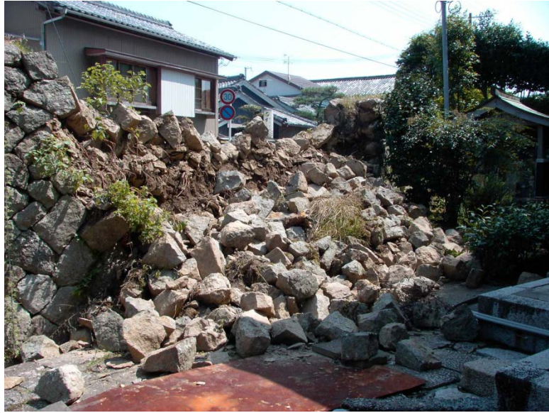
図 7-26 紀伊半島南東沖の地震による石垣の倒壊（和歌山県新宮市）[気象庁(2004)より]
