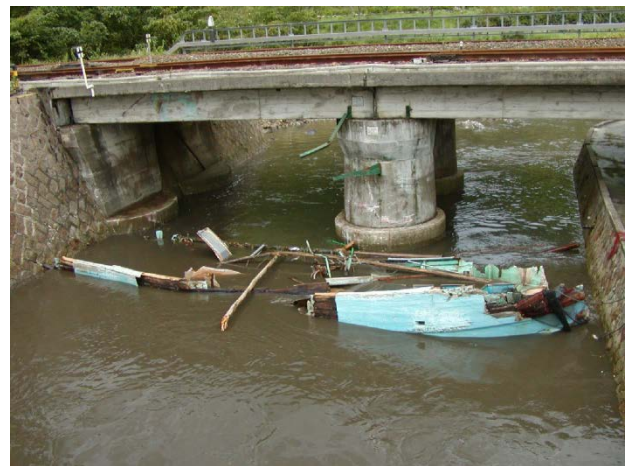
図 7-25 紀伊半島南東沖の地震による津波で破損した船 (三重県尾鷲市) [気象庁(2004)より]
