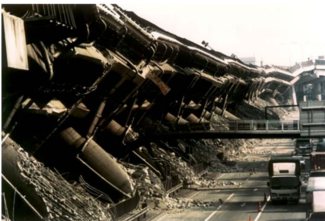
図 7-20 「平成 7 年 (1995 年) 兵庫県南部地震」により倒壊した高速道路 (阪神高速神戸線) [毎日新聞提供]
