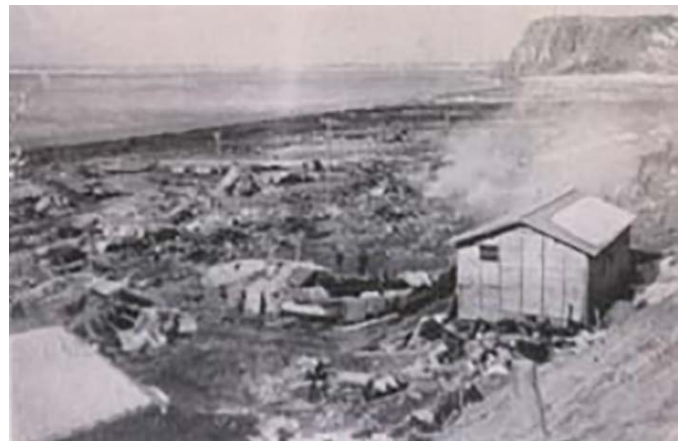
図 3-9 1952 年の十勝沖地震の津波による被害状況 (厚岸床潭部落) [中央気象台(1953)による]
