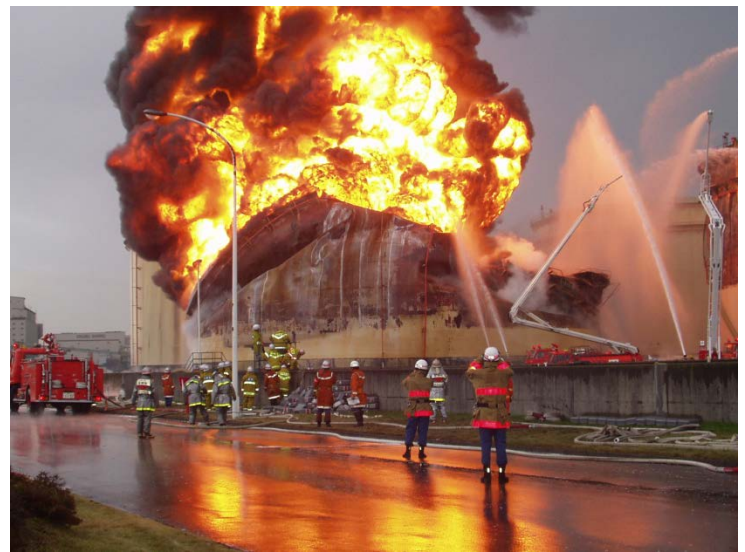
図 3-25 「平成 15 年（2003 年）十勝沖地震」の影響で火災が発生した苫小牧の石油タンク [総務省消防庁提供]
