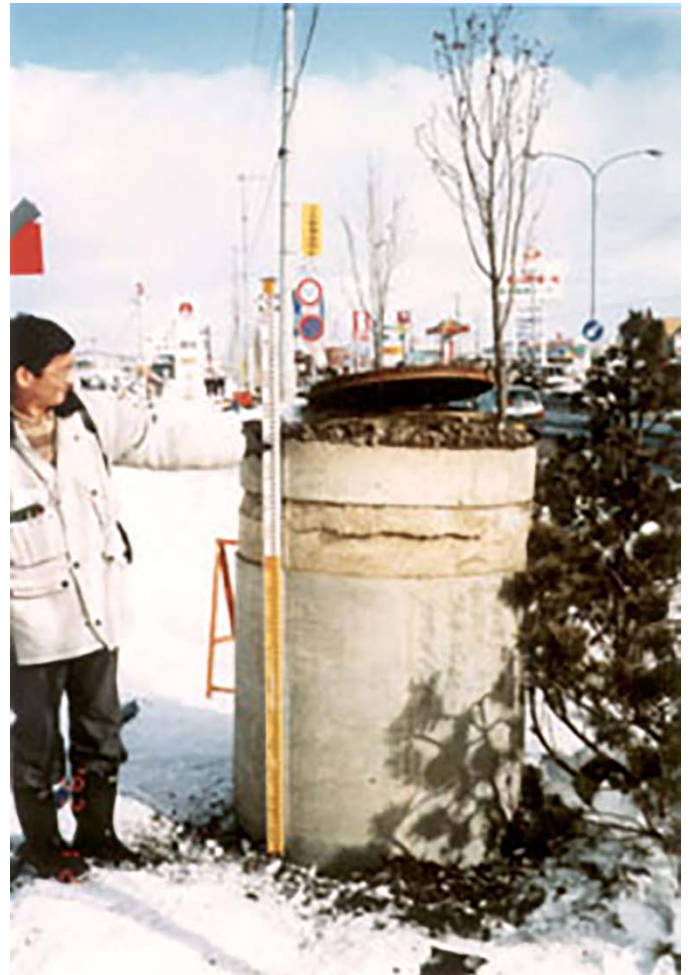
図 3-16 「平成 5 年（1993 年）釧路沖地震」の液状化現象によるマンホールの抜け上がり [釧路地方気象台提供]
