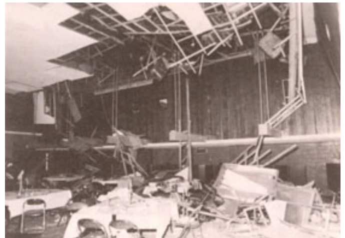
図 3-13 「昭和 57 年（1982 年）浦河沖地震」による浦河町福祉センターの天井落下 [浦河町提供]
