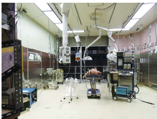
(a) 免震構造内の手術室
