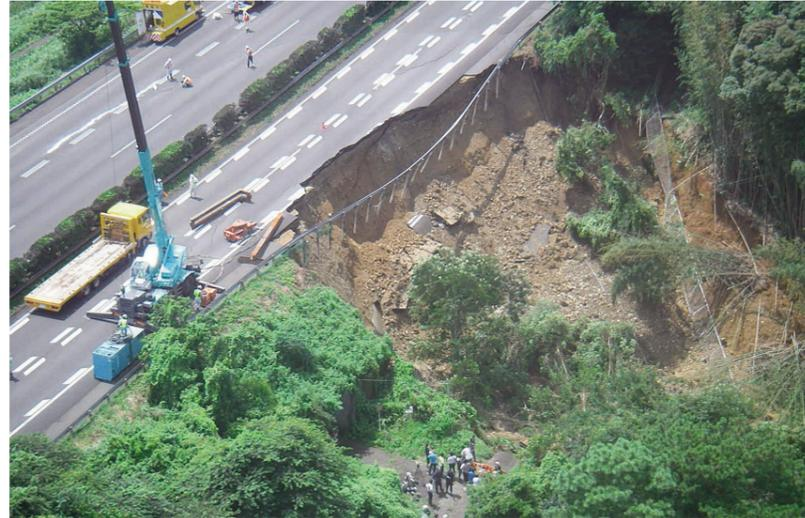
写真2 東名高速道路 牧之原市付近の盛土崩落(中日本高速道路株提供)
