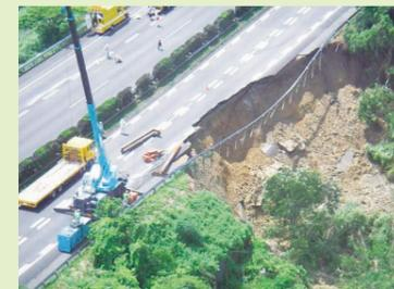
平成21年8月11日の駿河湾を震源とする地震による、東名高速道路牧之原市付近の盛土崩落現場（中日本高速道路（株） 提供）
