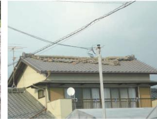
写真4 屋根瓦がずれた建物(牧之原市内)
