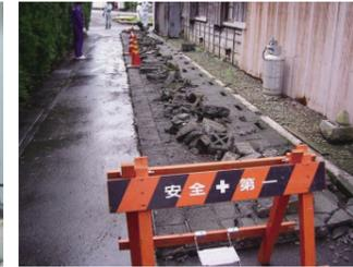
写真5 ブロック塀の倒壊(焼津市内)
