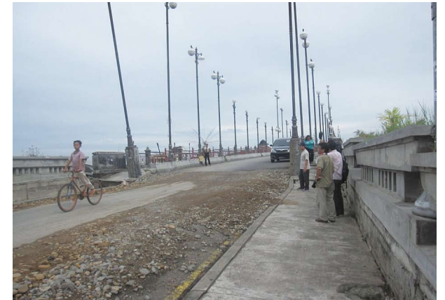
図6 海岸付近の橋梁も地震の被害を受けた（今村文彦氏撮影）
