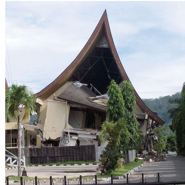
図4 2009年9月の地震によって被害を受けた伝統的スタイルの建物
