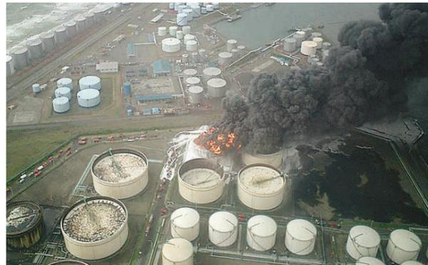
図1 2003年十勝沖地震によって発生した長周期地震動による苫小牧の石油タンク火災 総務省消防研究センター提供
