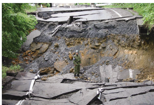
写真2 国道342号線の状況
