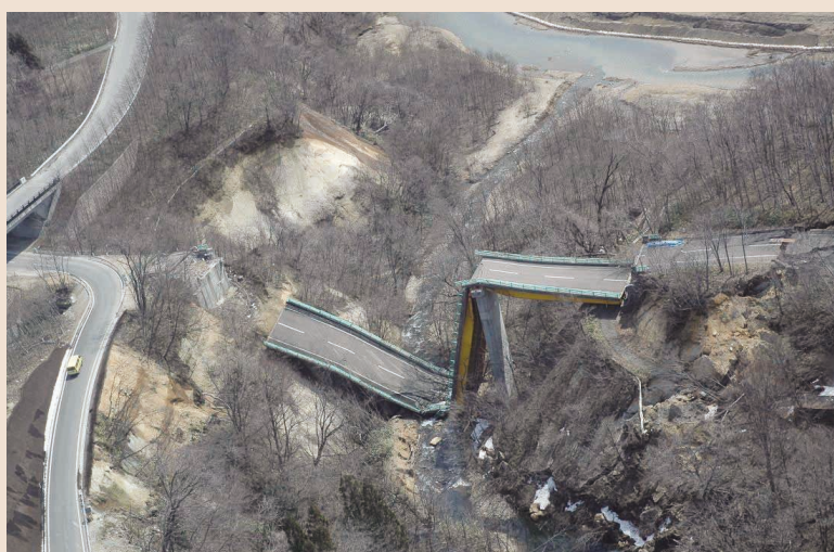
写真1 落橋した祭時(まつるべ)大橋
