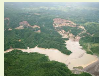
平成20年6月14日岩手・宮城内陸地震による 荒砥沢ダムでの大規模土砂災害 （朝日航洋株式会社 提供）
