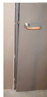
写真3 曲がったドアフレーム
