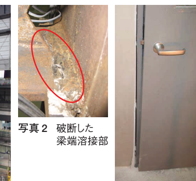
写真2 破断した梁端溶接部
