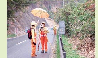
復旧測量 地震により動いてしまった三角点や水準点を再測量し、新たな測量成果を算出します。
