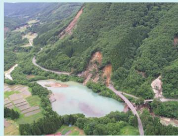
岩手・宮城内陸地震で発生した大規模斜面崩落とそれによる河道閉塞(天然ダム)
