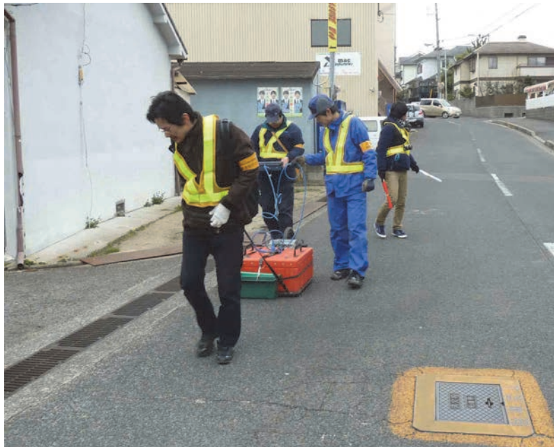
図 27 地中レーダー探査データ取得の作業風景。アンテナ前方の人間（茶色の服）が送受信アンテナを牽引して移動させ、アンテナ後方の人間（紺色の服）が送受信制御・データ収録を行う。また、図のように探査中は交通警戒を行う（アンテナ斜め後方の赤白の棒を持った人間）。
