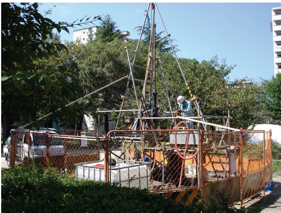
住之江撓曲西側（新北島西公園）掘削
