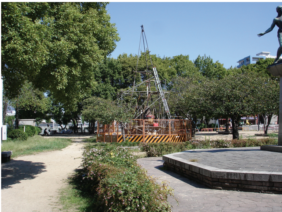
住之江撓曲東側（新北島東公園）掘削
