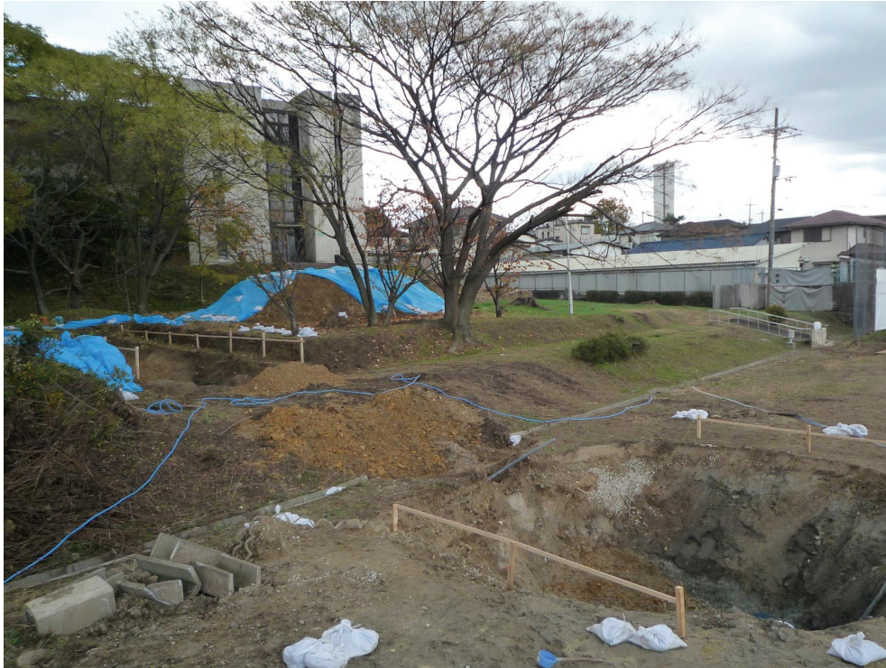
堺市堺区大仙町におけるトレンチ・ピットの調査風景 写真中央付近の段差を横断する地形地質断面を作成し、地層のずれを確認した。
