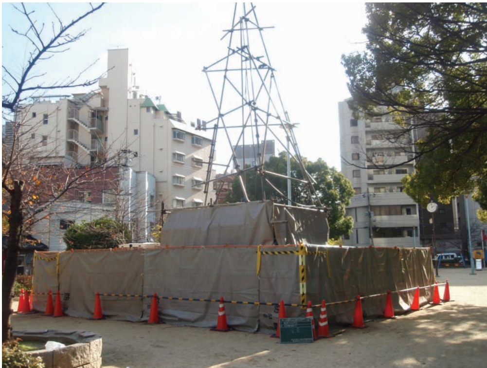
写真1 安全対策状況
