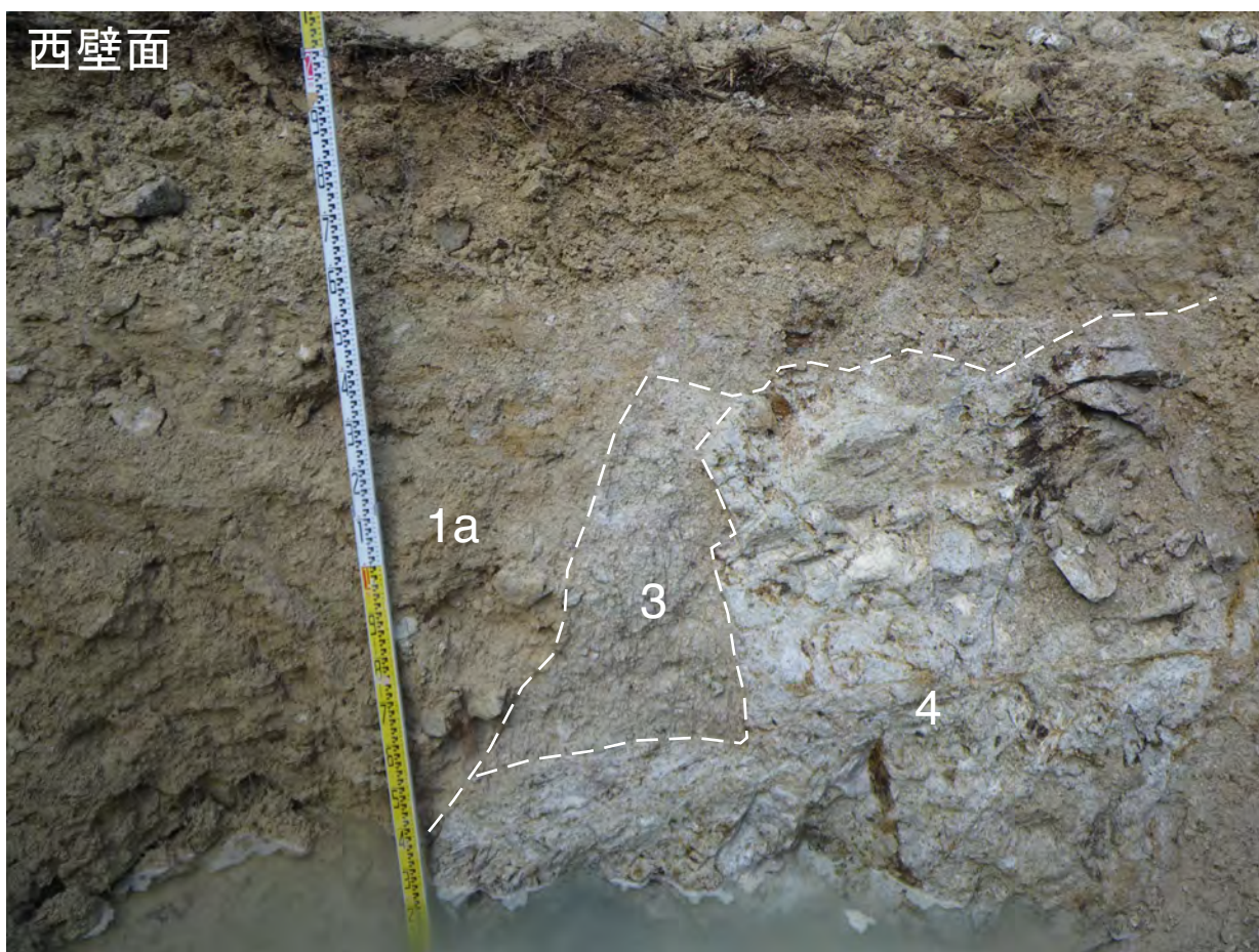
図9 西洞ピット壁面の写真
