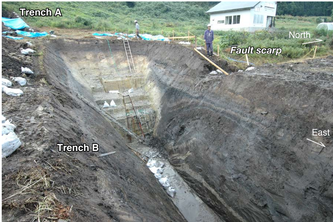
写真1 大石田町里山スキー場地点における断層崖とトレンチ壁面.
