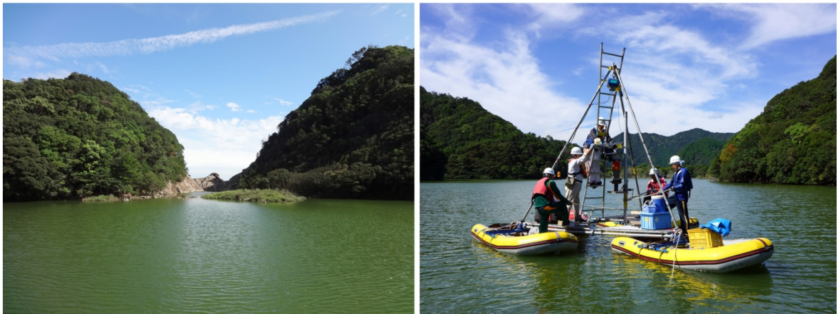
図 17. 須賀利大池の池の中心部より南側の開口部を望む（左）。コアリング作業写真。池の中心部より西側を望む（右）。
