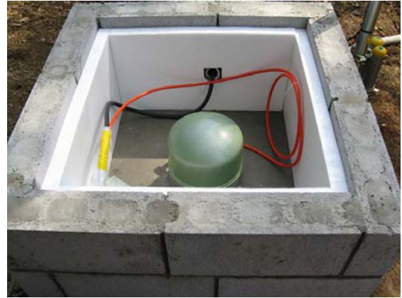
写真2 紀北紀伊長島観測点の地震計室
