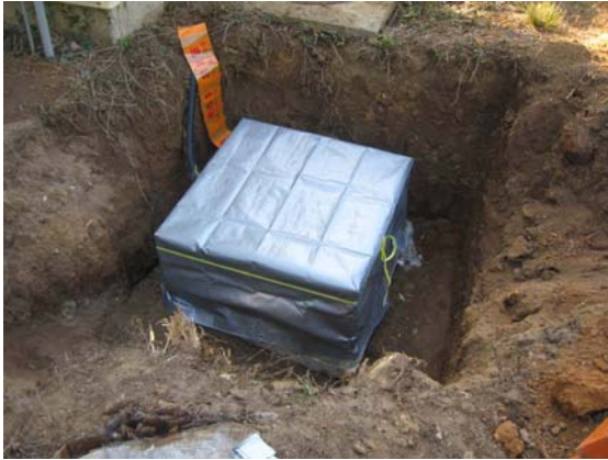
写真1 赤羽根観測点の地震計室
