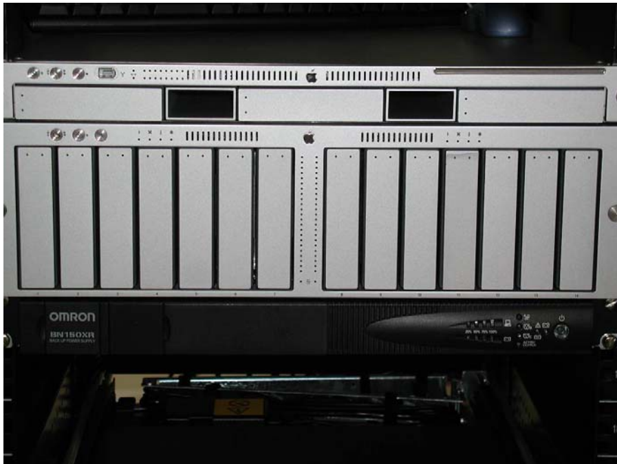
写真6 新規整備した海底地震計データの1次処理装置
