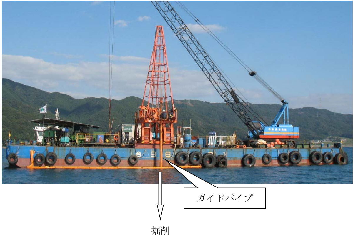
図 40 傾動自在型試錐工法
