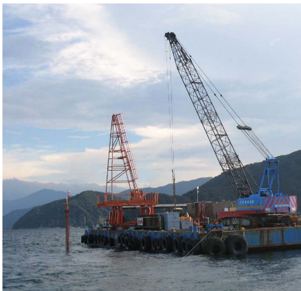
図 41 ガイドパイプを台船から隔離した様子
