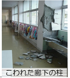
こわれた廊下の柱
