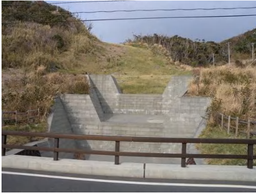
写真 砂防ダム
