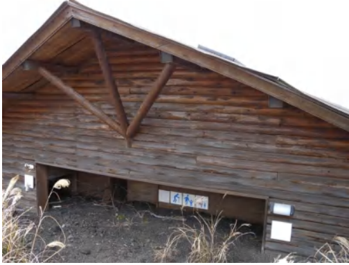
写真 複数回の泥流で埋もれたトイレ
