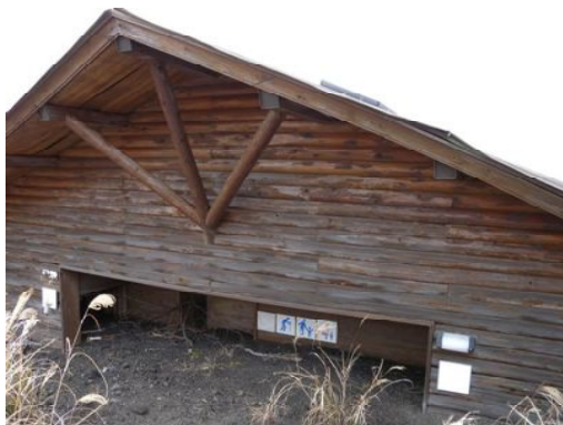
写真 複数回の泥流で埋もれたトイレ
