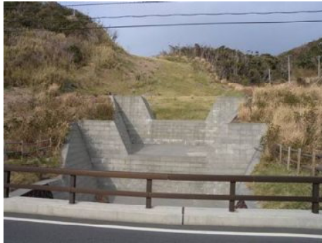
写真 砂防ダム
