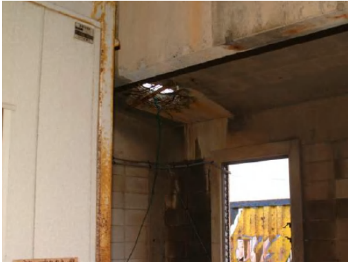
写真 建物を貫通した噴石のあと
