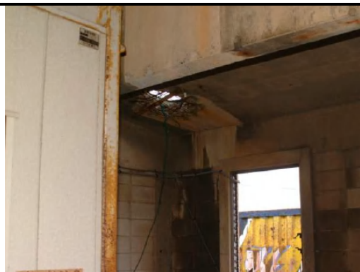
写真 建物を貫通した噴石のあと
