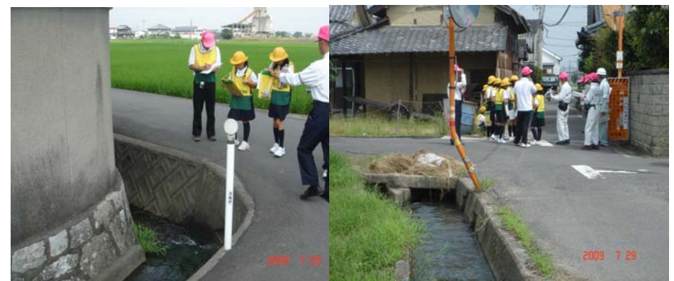
危険な水路と浸水しやすい区間
